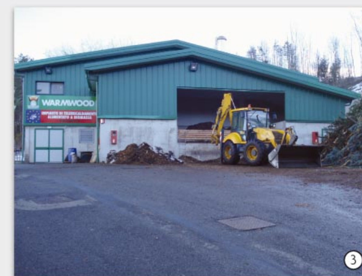
Centrale di teleriscaldamento a biomasse forestali
